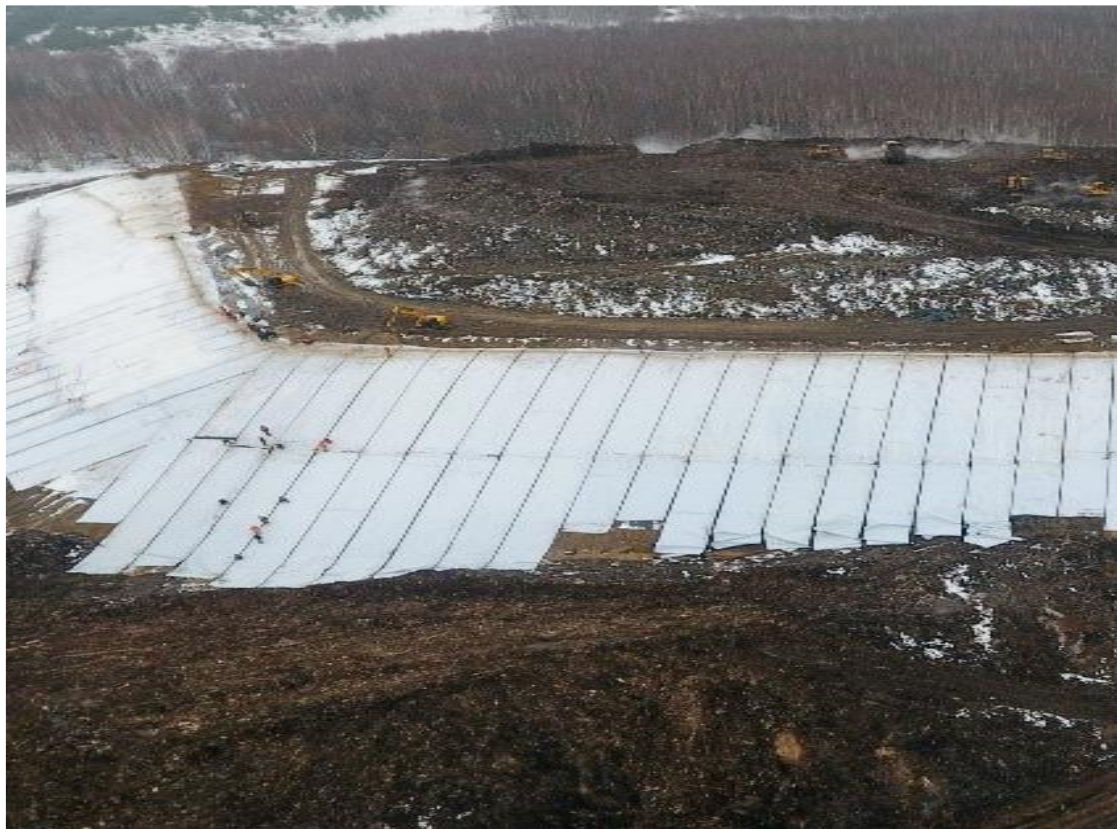
▪ При обустройстве полигонов ТБО
