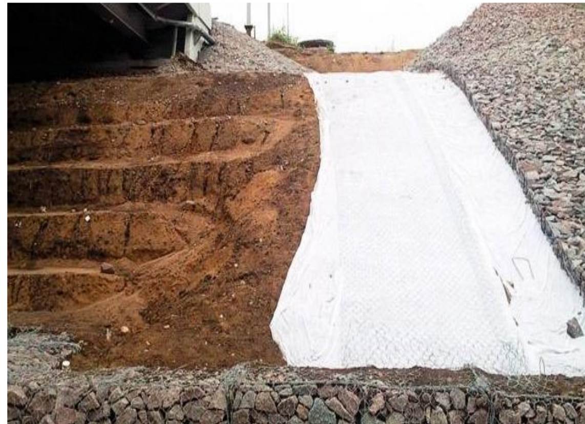
▪ Укрепление насыпей при строительстве мостов
